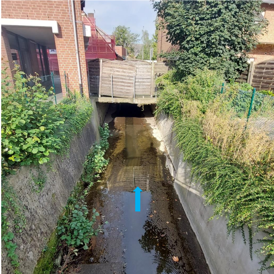
Abbildung 13: überbauter Brüggenbach oberhalb der Industriestraße, beidseitig Ufermauern, NW-Rinne mit Betonbermen Stat. 4+270
