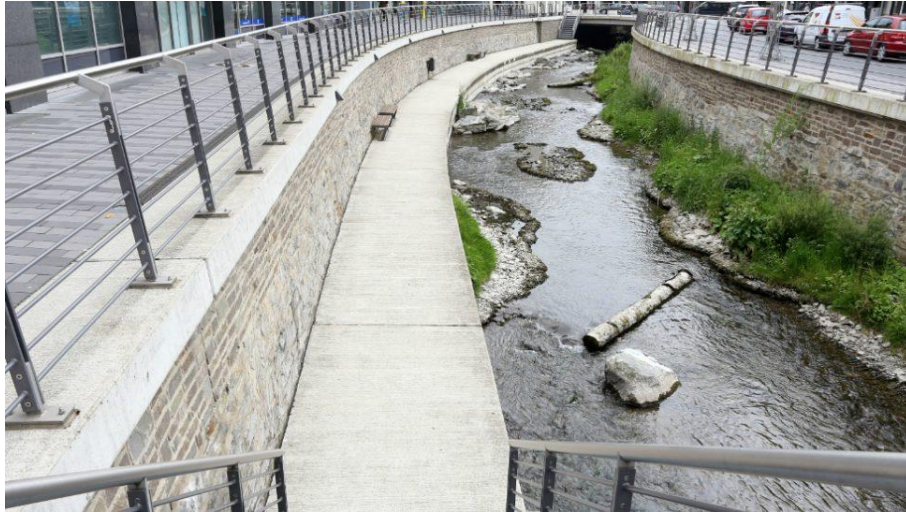
Abbildung 21: Freilegung der Henne mit Sohlstrukturierung aus Kiesbänken und Totholz (www.meyer-tochtrop.de)
