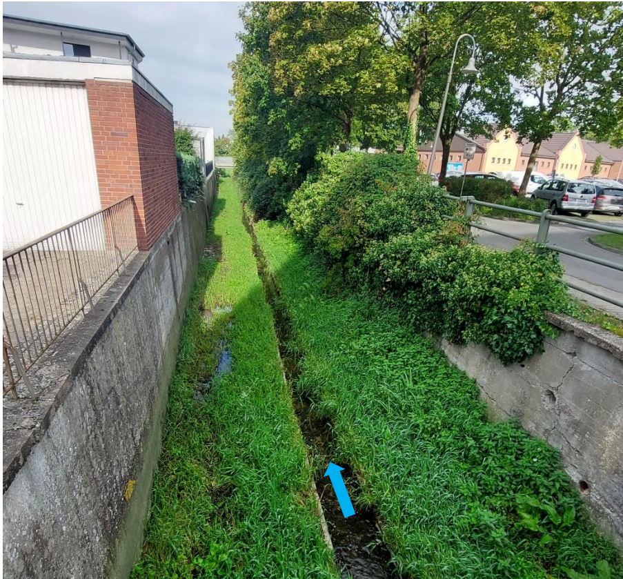
Abbildung 11: beidseitig Ufermauern, rechts: Parkplatz Einzelhandel, Stat. 4+200
