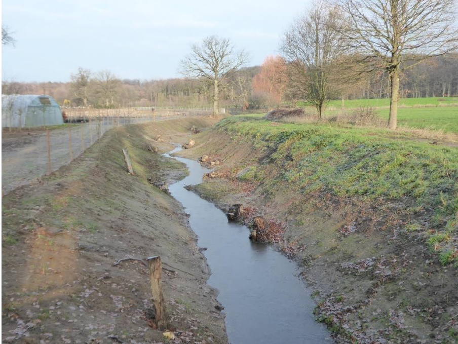
Abbildung 19: Beispiel für eine Aufwertung innerhalb des Gewässerprofils mit Einsatz von Totholz (Helmerbach in Senden-Bösensell)
