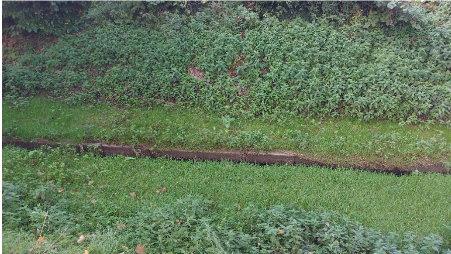
Abbildung 9: Niedrigwasserrinne aus Randsteinen (Beton) und Erdbermen
