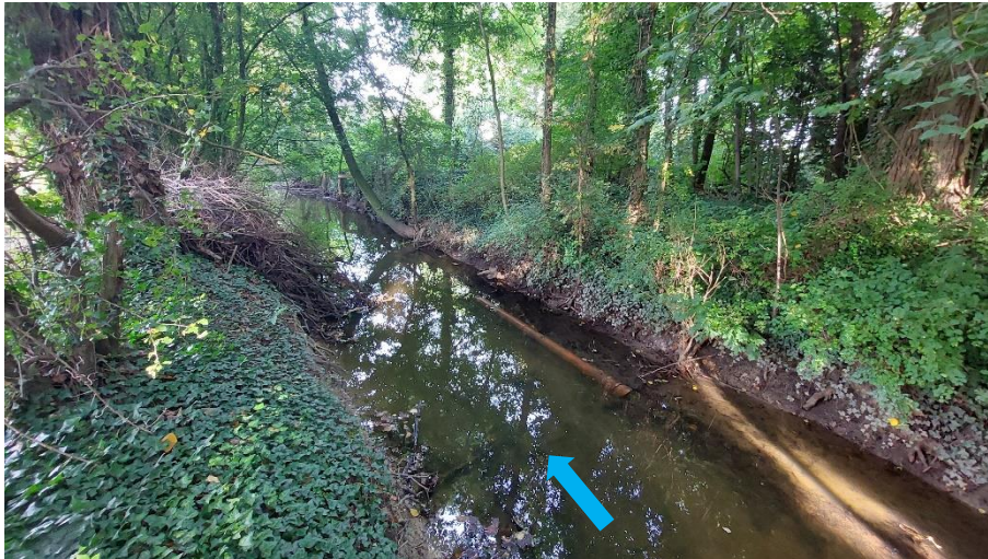
Abbildung 16: Kastenprofil unterhalb der Eisenbahnstraße, beidseitig Gehölze, Rückstaubereich der Betonbermen ohne Strömungsgeschwindigkeit, Stat. 4+800
