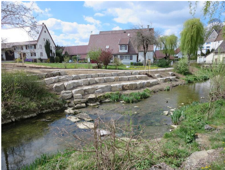
Abbildung 20: Beispiel für den Ersatz einer Ufermauer durch Blocksteine (Gemeinde Dautmergen)
